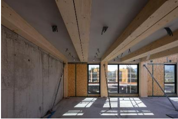
Fig. 1 Construction of CE 1 (Grupo Casais, 2021)
